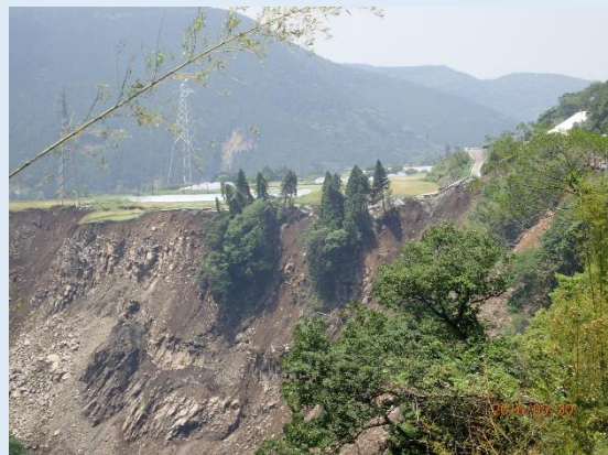
熊本地震後の土砂崩れの様子 (金田義行氏 提供)
